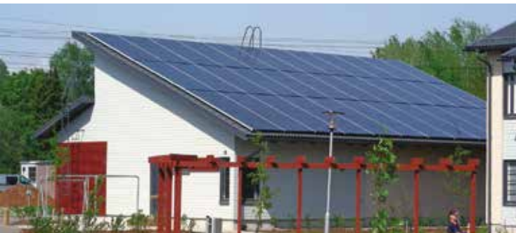
Rivitaloyhtiön tekninen tila Espoossa, huipputeho 24 kW.
